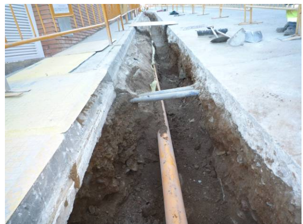
59. Rasa oberta per a la canonada de 225 al carrer de Saldes.
