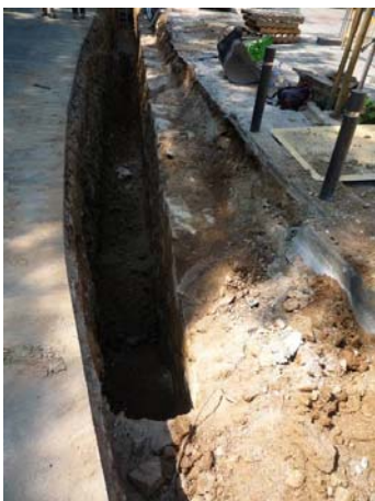
11. Tram de mur localitzat
