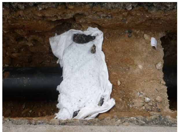
47. Protecció de la claveguera UE 27 amb geotèxtil.
