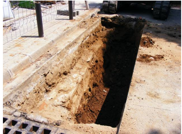
10. Tram de mur UE 14, tallat per un desguàs de clavegueram.
