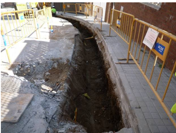
58. Rasa oberta per a la canonada de 225 al carrer de Saldes.
