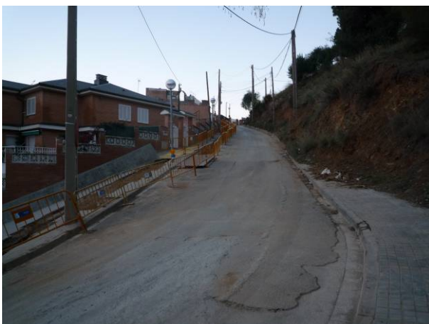
64. Tram on es va iniciar la rasa, al carrer Saldes.
