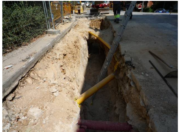
33. Finalització de la rasa al creuament amb l'avinguda Jordà.
