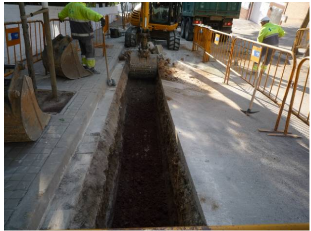
61. Obertura de la rasa per a la canonada de 400 al carrer Saldes
