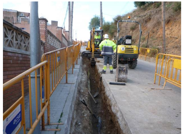
57. Obertura de la rasa per a la canonada de 225 al carrer Saldes
