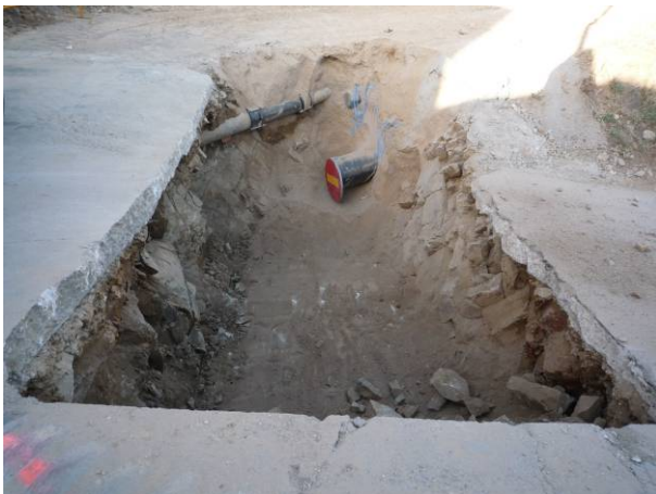
50. Rasa oberta al creuament del carrer de Saldes.
