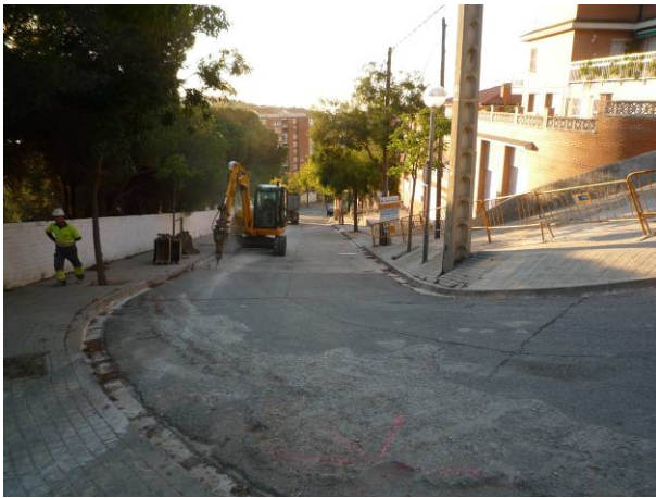
60. Tram on es va iniciar la rasa per a la canonada de 400, al carrer Saldes.
