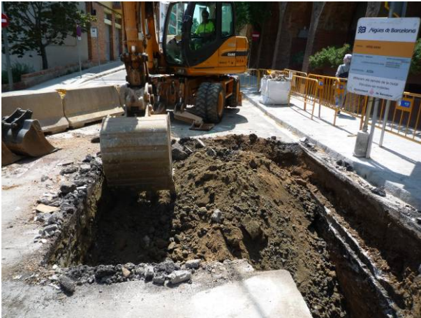
15. Excavació de l'arqueta.
