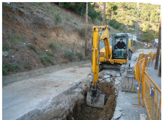
65. Obertura de la rasa al carrer Saldes
