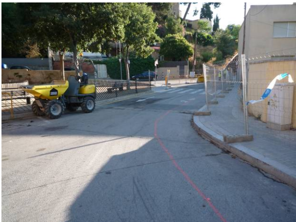
20. Tram on es va iniciar la rasa, al carrer Natzalet.
