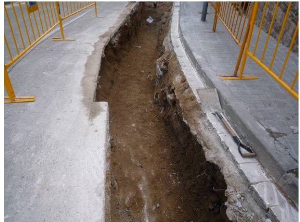
63. Rasa oberta per a la canonada de 400 al carrer de Saldes.
