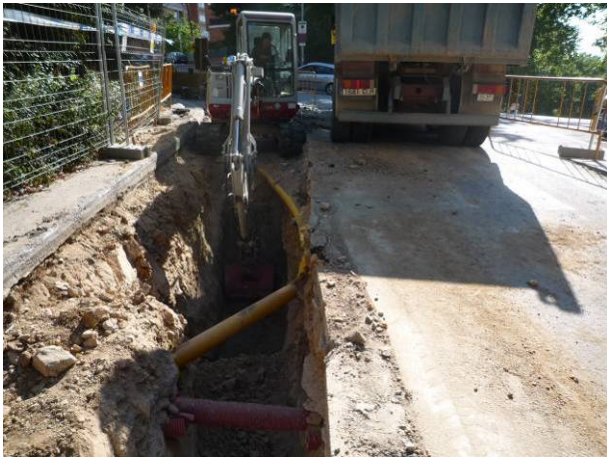
32. Excavació de la rasa propera a l'avinguda Jordà.
