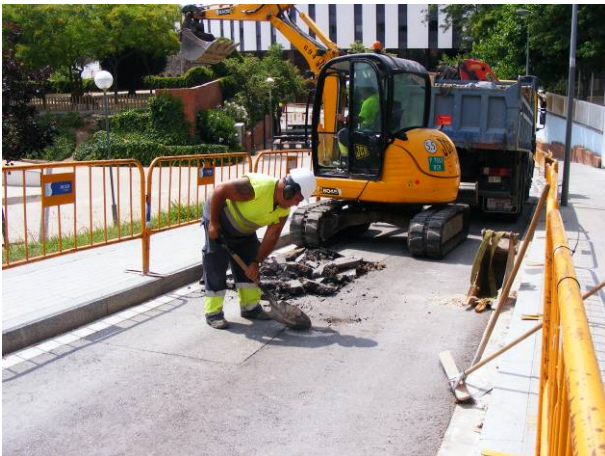
3. Obertura de cales de sondeig abans de l'inici de l'obra..
