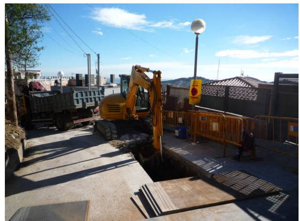
53. Obertura de la rasa al carrer Saldes.
