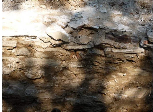
14. Detall de la factura del mur UE 14.
