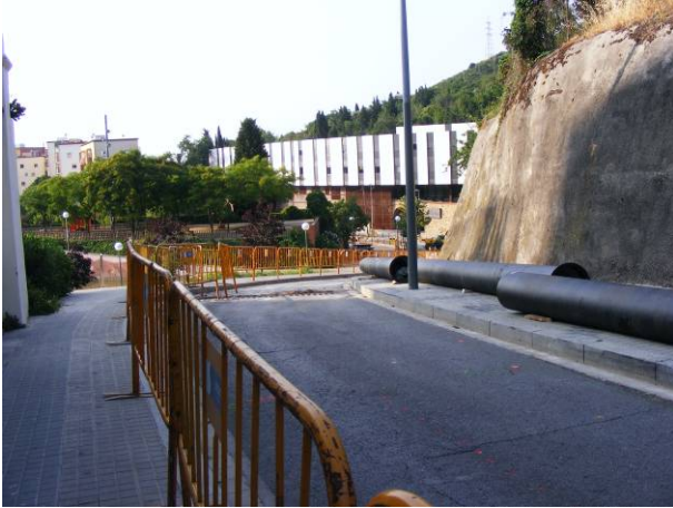
1. Tram on es va iniciar la rasa, al carrer Natzaret.
