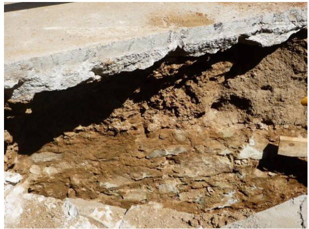
37. Detall del mur UE 23.
