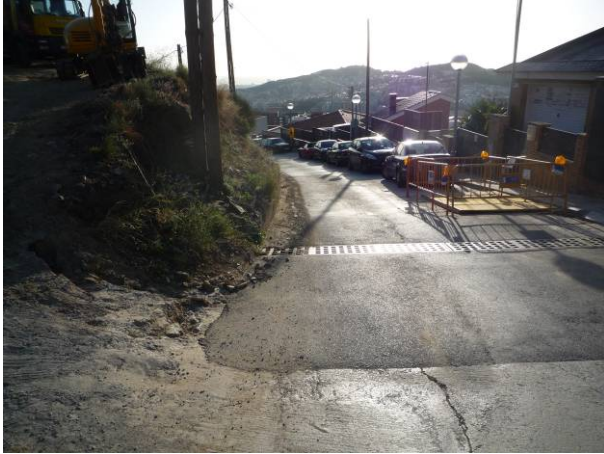
48. Tram on es va iniciar la rasa, al carrer Saldes.
