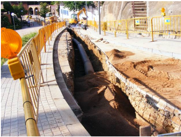
7. Rasa i canonada al tram central del carrer
