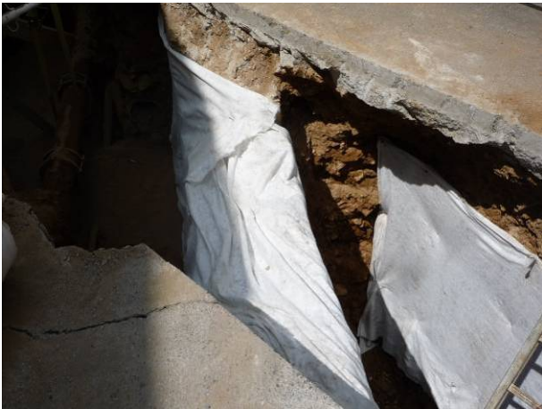
38. Protecció del mur UE 22 amb geotèxtil.
