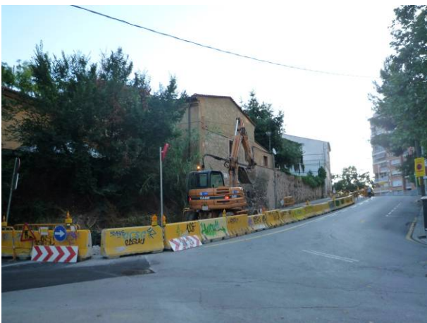
40. Tram on es va iniciar la rasa, al carrer Natzaret.
