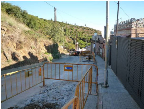
56. Tram on es va iniciar la rasa per a la canonada de 225, al carrer Saldes.
