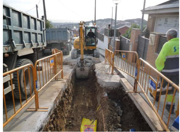
49. Obertura de la rasa al carrer Saldes.
