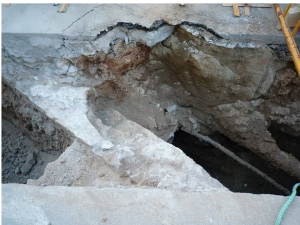
34. Mur UE 22 al costat de diversos serveis.
