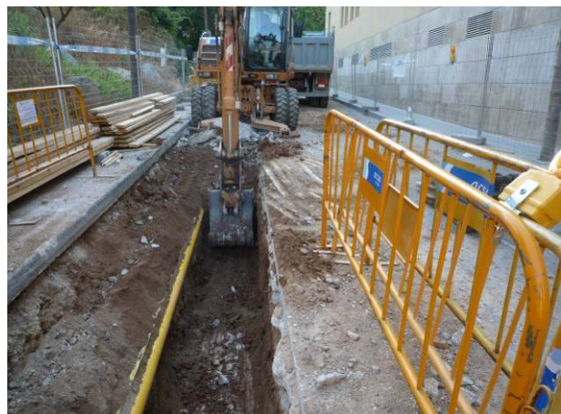
29. Obertura de la rasa al carrer Natzaret amb el servei de gas.
