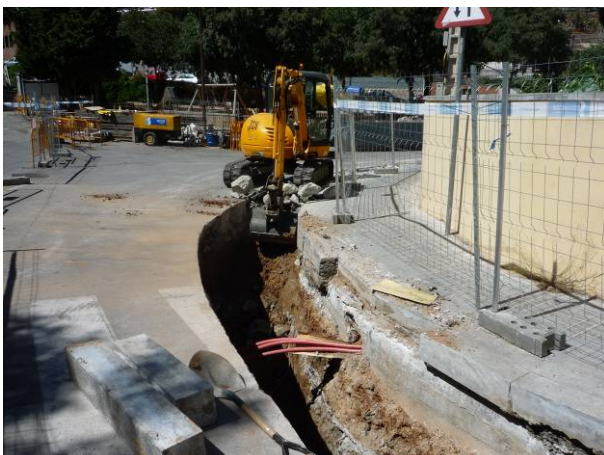
22. Obertura de la rasa.
