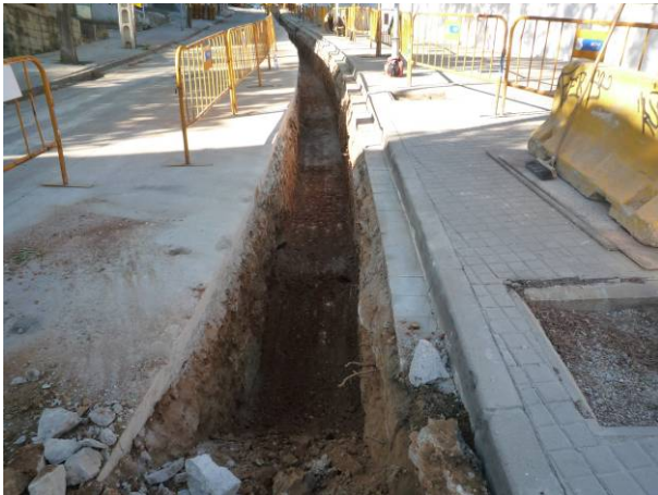
62. Rasa oberta per a la canonada de 400 al carrer de Saldes.
