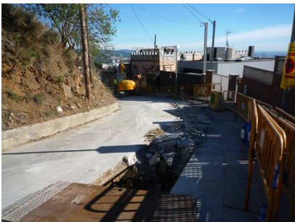
52. Tram on es va iniciar la rasa, al carrer Saldes.
