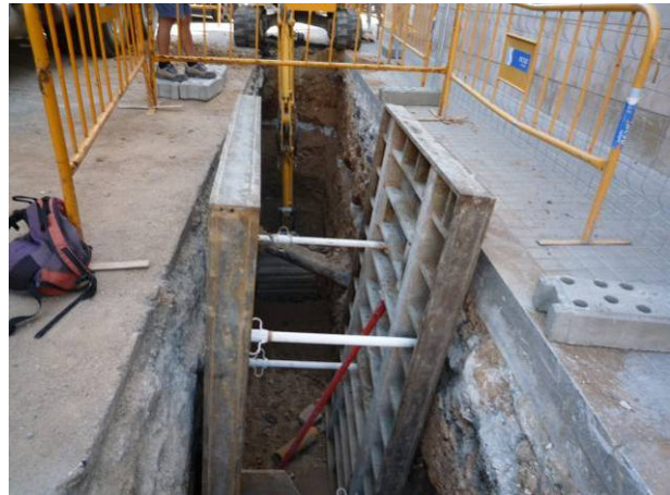
27. Excavació per sota del col·lector del carrer Natzaret.
