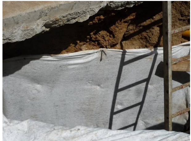
39. Protecció del mur UE 23 amb geotèxtil.
