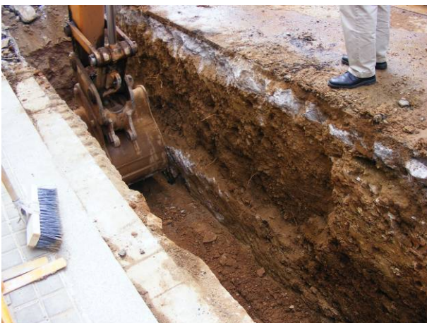
5. Rasa de clavegueram i col·lector
